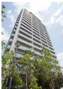
ブランシエラ浦和 (平成21年竣工)
