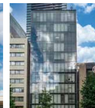
近鉄虎ノ門ビル(東京都港区) 東京メトロ日比谷線「虎ノ門ヒルズ」駅徒歩1分 東京メトロ銀座線「神谷町」駅徒歩7分
