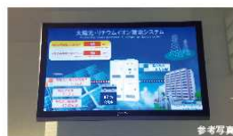
共用部に設置したテレビモニター
