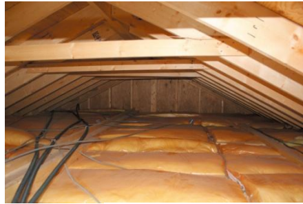
天井裏断熱材（参考写真）
