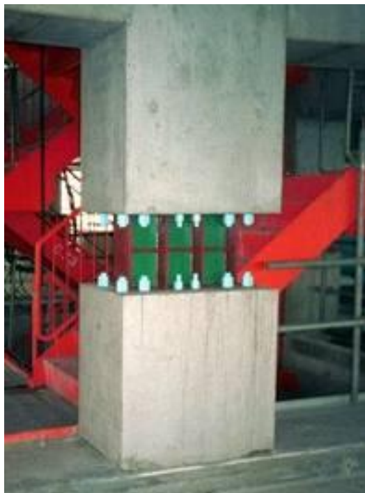
制震柱施工事例
